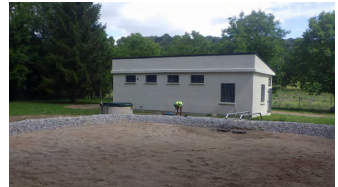
BASSIN DE FILTRATION
