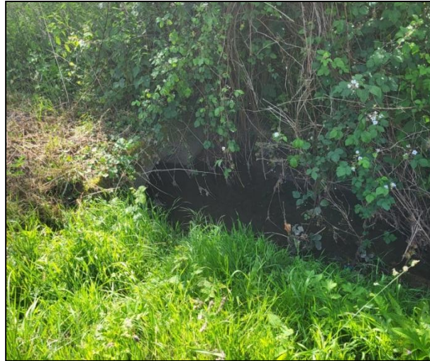
Figure 19 : Exutoire du réseau d'eaux pluviales à la sortie ouest de la commune de Hautefontaine (Mai 2022)
