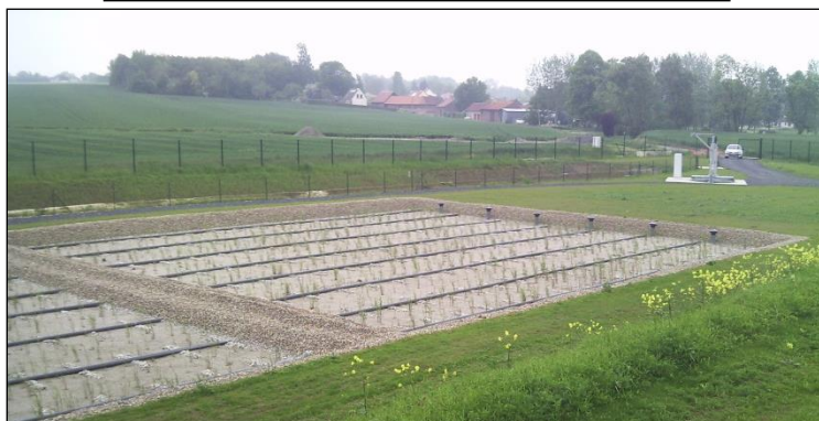
Station de traitement des eaux usées de type filtres plantés de roseaux (Altereo – Mai 2012)
