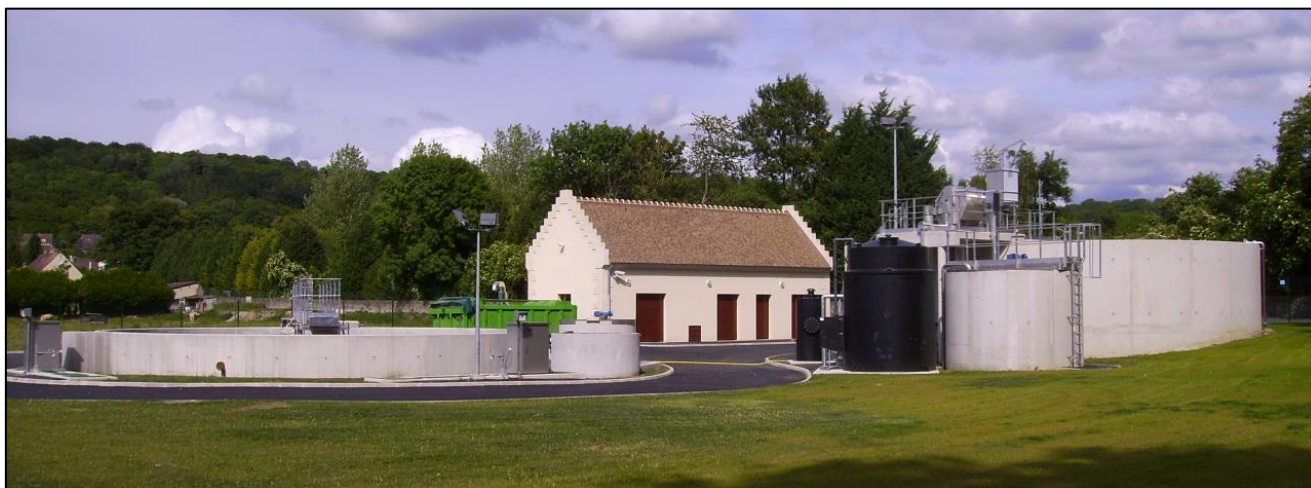
Station de traitement des eaux usées de type boues activées (Altereo – Mai 2011)
