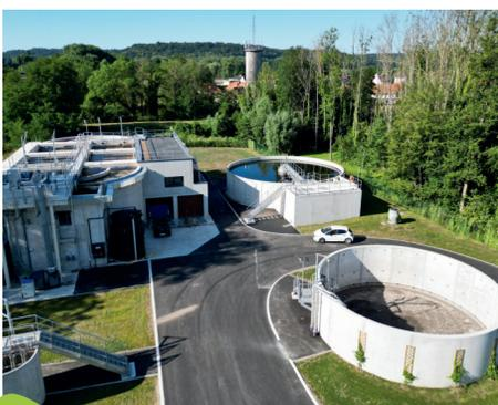
**Qu'est-ce qu'un bassin d'orage ?** Il s'agit d'un ouvrage conçu pour stocker le surplus des eaux usées (principalement des eaux pluviales, mélangées aux eaux usées) lors de fortes précipitations. Il soulage temporairement la station d'épuration et évite sa saturation, les eaux stockées sont ensuite progressivement réinjectées dans la station d'épuration.
