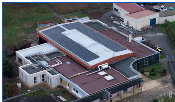
Installation PV* sur la toiture de la mairie et de la salle polyvalente à Bailleul-sur-Thérain
